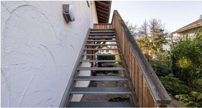
Treppe zur Einliegerwohnung
